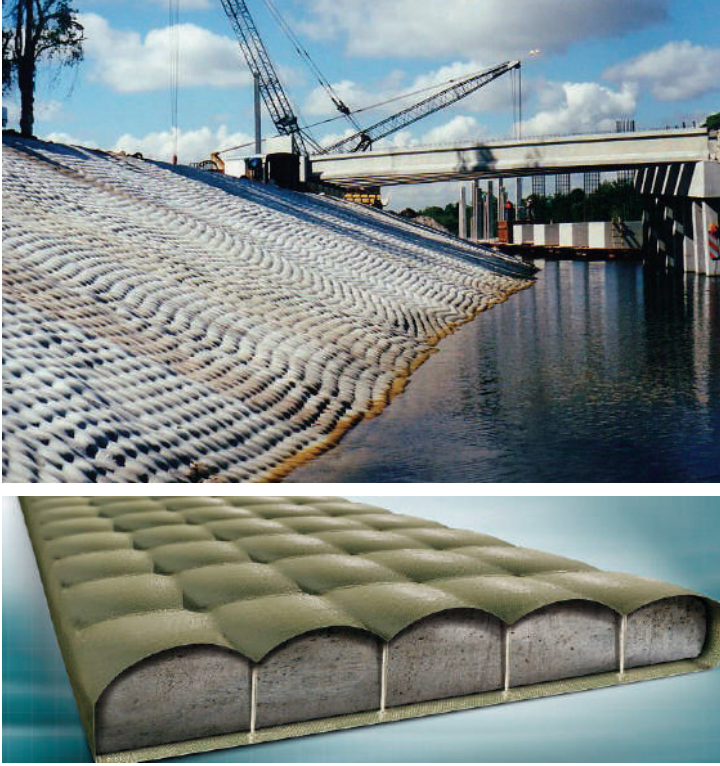
Şekil 28. Kanalın Yanal Yüzeyinde Planlanan Geosentetik Beton Şilte
