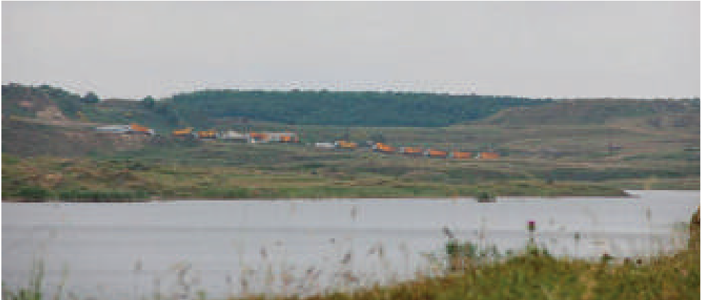
Fotoğraf 12. 3. Havalimanı İnşaat Çalışması
